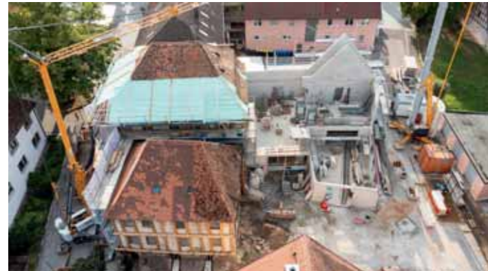
Stand der Bauarbeiten am 12.09.2023.
